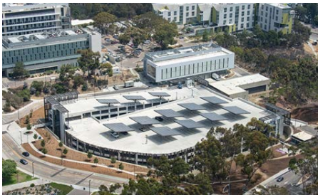
Osler Solar Array
